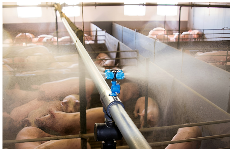
Rys. 4. Dysze systemu chłodzenia mogą być wykorzystywane także do dezynfekcji obiektu (fot. www.meier-brakenberg.de )
