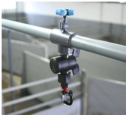
Rys. 4. Dysze systemu chłodzenia mogą być wykorzystywane także do dezynfekcji obiektu (fot. www.meier-brakenberg.de )
